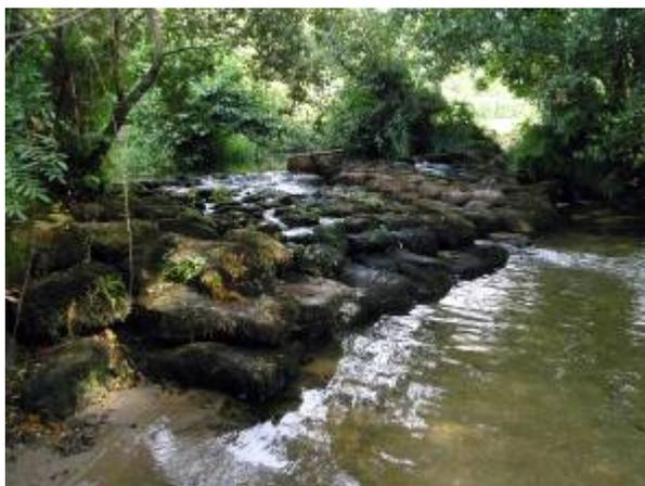
**Figura 29.** Açude em alvenaria para um moinho (HOS 01).
