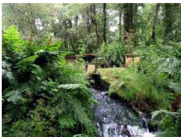
**Figura 28.** Açude de alvenaria com comportas (FUR\_01).
